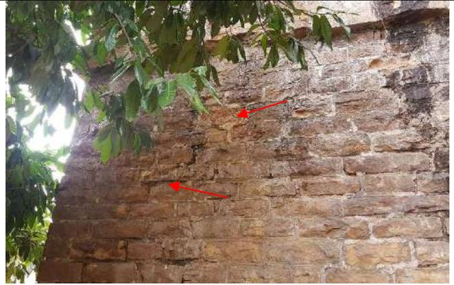
*Pile 4 côté Vil : joints dégarnis et moellons éclatés*
