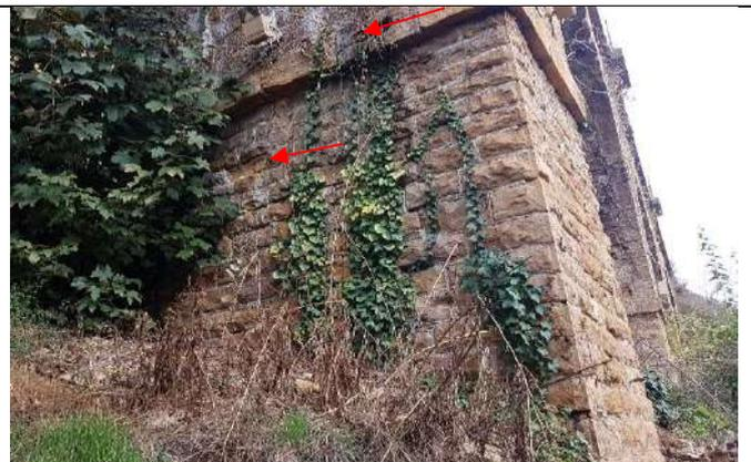
*Pile 3 côté Tarare : Cordon sous naissance et moellons éclatés ainsi que joints dégarnis*
