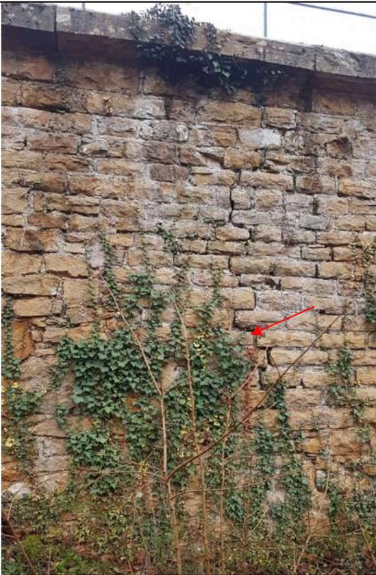
*Extrémité du tympan côté gauche Tarare : fracture verticale dans joints*
