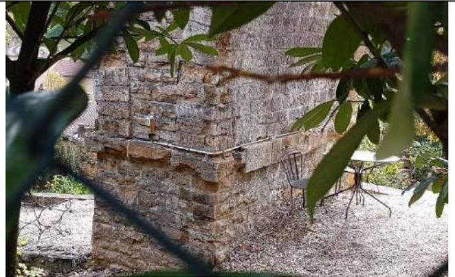
*Pile 5 côté Tarare : Pierres de taille du cordon sous naissance et moellons éclatés*
