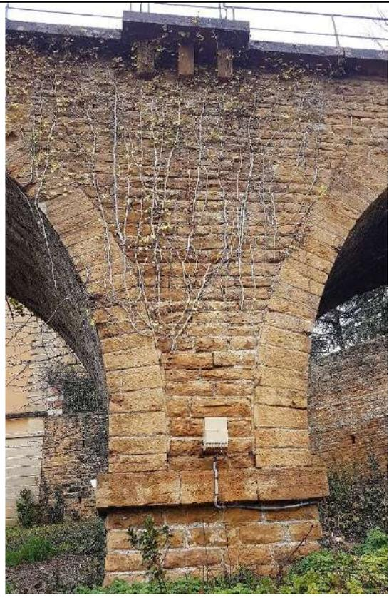
*Tympan côté gauche au droit de la pile 1 : joints dégarnis*
