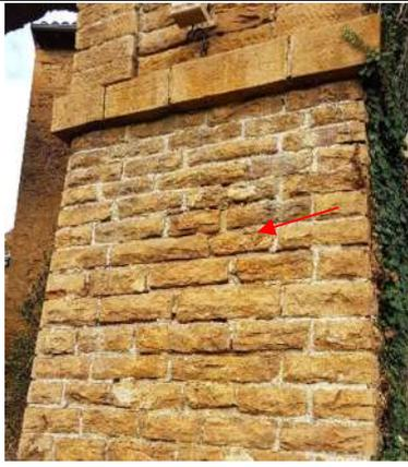
*Pile 3 côté gauche : joints dégarnis*
